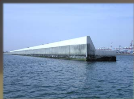
平成26年度 名古屋港外港地区防波堤（鍋田堤）嵩上工事
